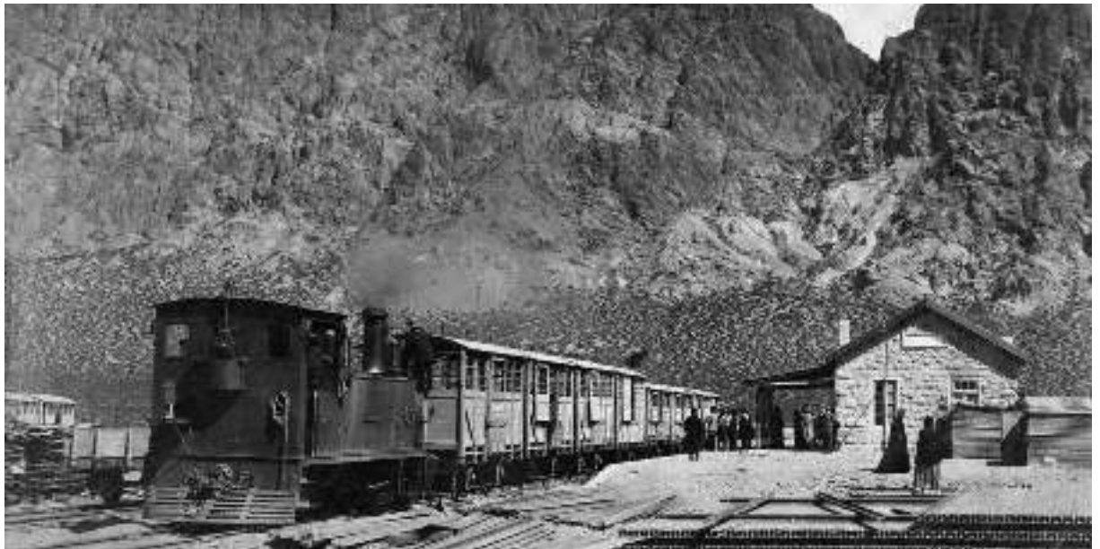
Estación Uspallata del Ferrocarril Trasandino (Archivo General de la Nación, Argentina).
